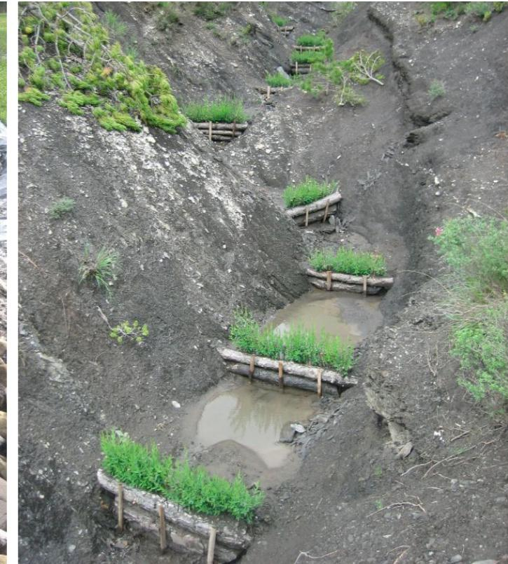
Tereplépcsőzés, átbukó vízlépcső kialakítása
