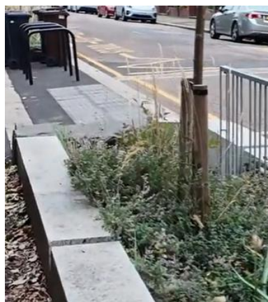
32. ábra Drénboxos szivárogtató árok, csatornarendszerbe túlfolyóval, járdába épített vízvezető felszíni kifolyóval
