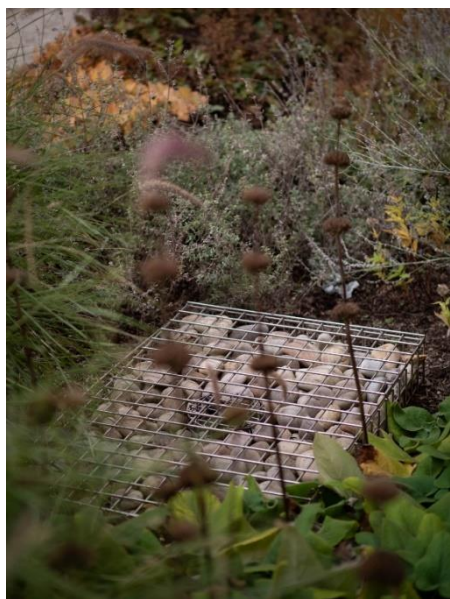
32. ábra Drénboxos szivárogtató árok, csatornarendszerbe túlfolyóval, járdába épített vízvezető felszíni kifolyóval
